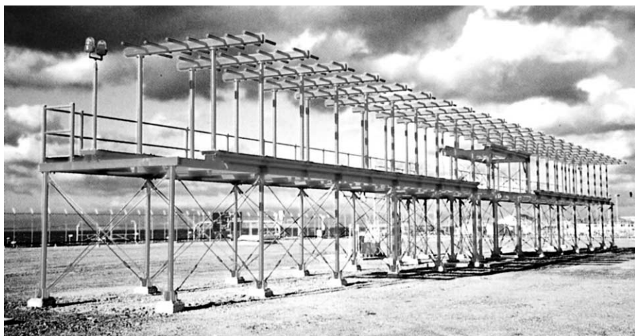
〈写真1〉 ILSローカライザ用LPDAアンテナLP-1012B [アンテナ技研(株)]
