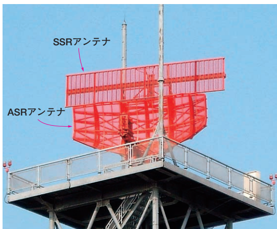
〈写真1〉(K) ASR/SSR アンテナ
