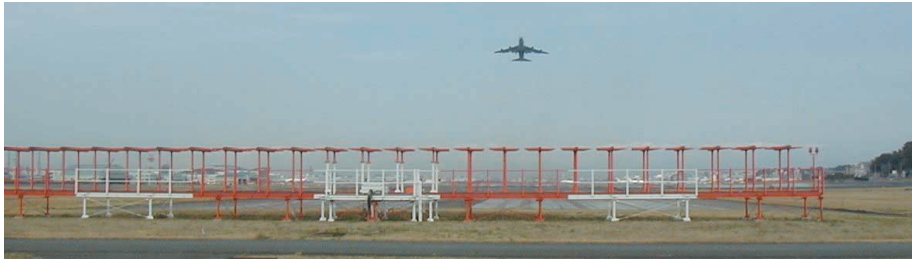
〈写真4〉 ローカライザ用アンテナ施設(特集 第2章)
