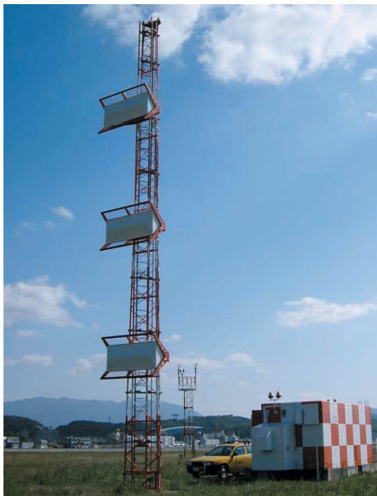
〈写真1〉 グライド・スロープのアンテナ施設(特集 第2章)
